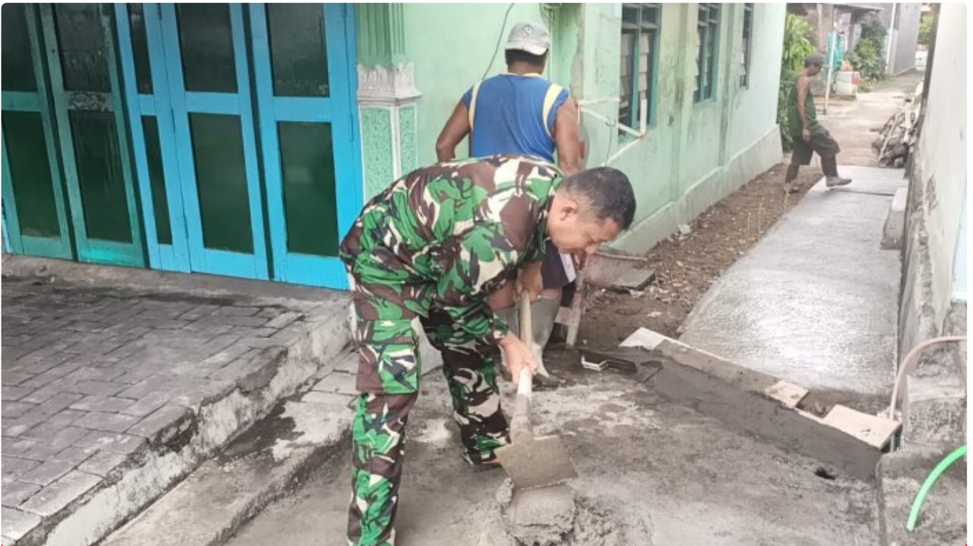
Ringankan Warga Binaan, Babinsa Koramil Prambanan Bantu Perbaiki Jalan Gang
